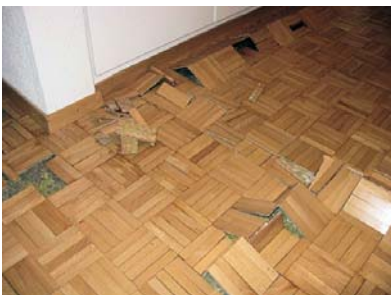
Das ausströmende Wasser hat einen grossen Schaden an den Bodenbelägen hinterlassen.
