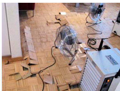
Das ausströmende Wasser hat einen grossen Schaden an den Bodenbelägen hinterlassen.
