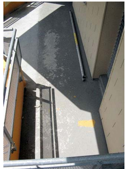
Die alten, zum Teil undichten Balkonböden vor den Sanierungsarbeiten
