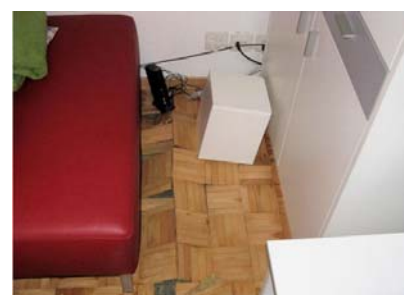
Das ausströmende Wasser hat einen grossen Schaden an den Bodenbelägen hinterlassen.
