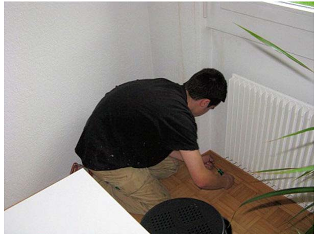
Nach den Austrocknungsarbeiten konnte mit dem Verlegen der neuen Beläge begonnen werden.
