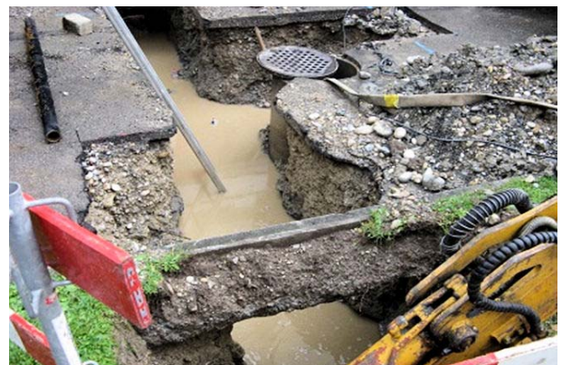
Die Wasserleitung musste für die Reparaturarbeiten freigelegt werden
