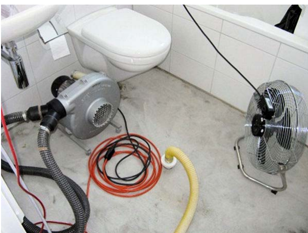
Nach den Austrocknungsarbeiten konnte mit dem Verlegen der neuen Beläge begonnen werden.
