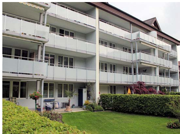
Balkone nach der Sanierung
