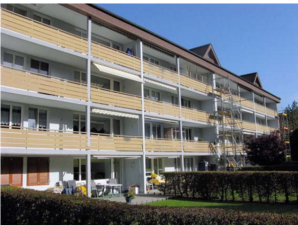
Balkone vor der Sanierung
