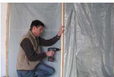
Provisorium für Staub- und Kälteschutz im Treppenhaus
