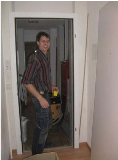
Montage der neuen Türen
