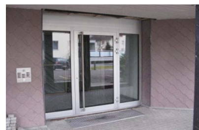
Die Türen sind montiert
