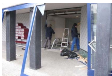
Einbau der neuen Türen
