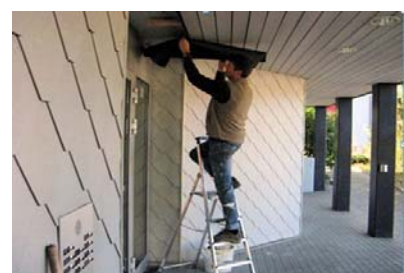
Fertigarbeiten nach der Türmontage
