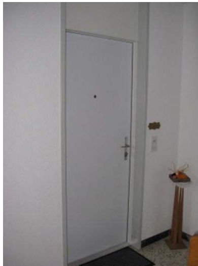
Die neuen Türen sind montiert
