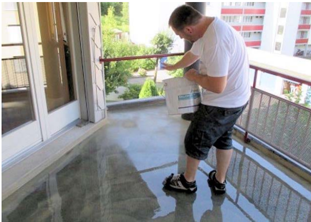
Als Antirutsch-Schutz wird die noch «nasse» Versiegelung mit Quarzsand bestreut.
