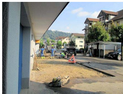
Belagsausbruch und ausgleichen des bestehenden Untergrundes
