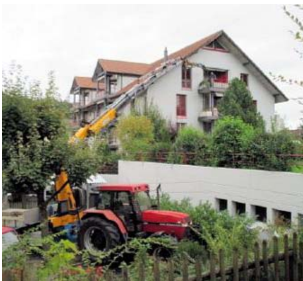
Das Herunterheben der Blumentröge verlangte vom Kranchauffeur einiges ab, war es doch oft eine Millimeterarbeit. Zudem wog ein Behälter ca. 250 Kilogramm.
