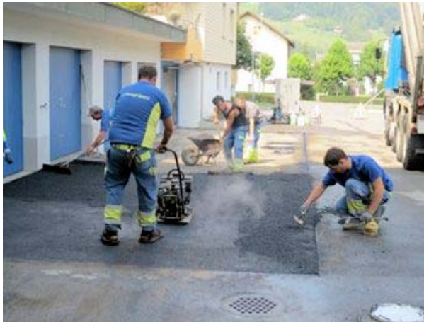
Einbau des neuen Asphalt-Belages durch die Firma Hans Renggli Malters
