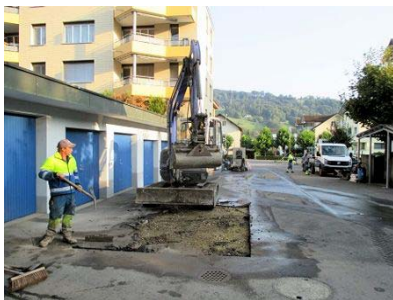
Belagsausbruch und ausgleichen des bestehenden Untergrundes
