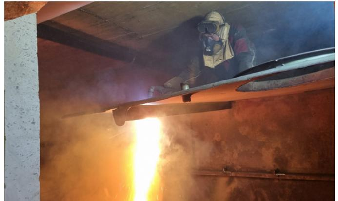
Die Stahltänke werden mit einem speziellen Schweißbrenner in kleinere Teile zerlegt und abtransportiert. Dabei entstand sehr viel Rauch und Lärm.
